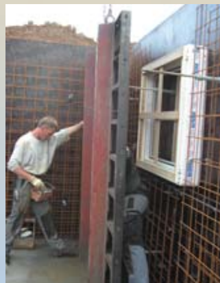
Po założeniu wewnętrznego szalunku możemy przystąpić do betonowania
