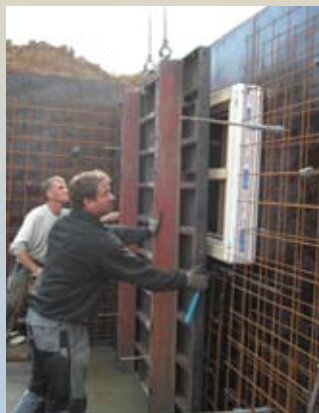
Po założeniu wewnętrznego szalunku możemy przystąpić do betonowania
