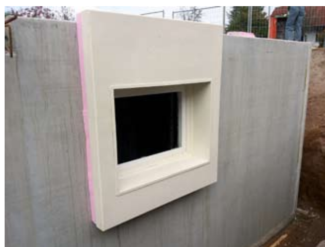
Okno ościeżnicowe, rama zabezpieczająca izolację oraz izolacyjny element montażowy składają się na perfekcyjny system.
